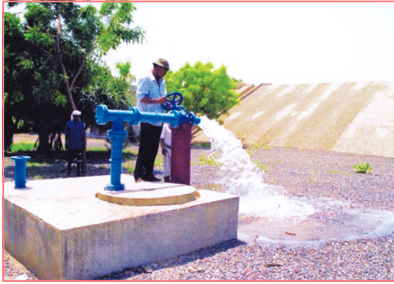
الشكل (١٤) مضخة ارتوازيه تسحب الماء من جوف الأرض
